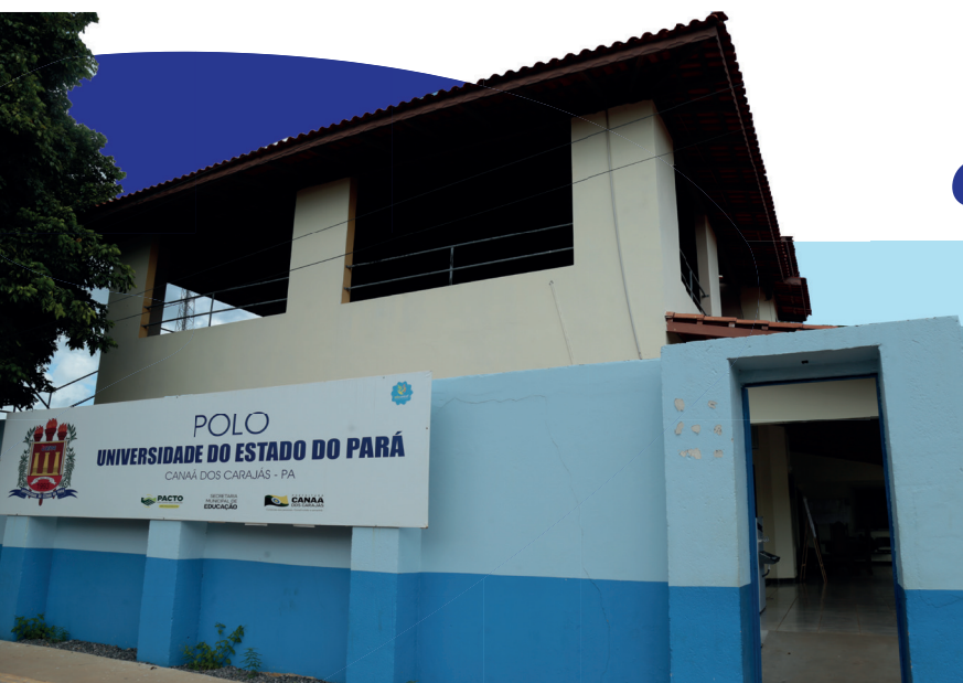
Fachada do Polo em Canaã dos Carajás em 2024 Foto: Acervo Ascom Uepa
